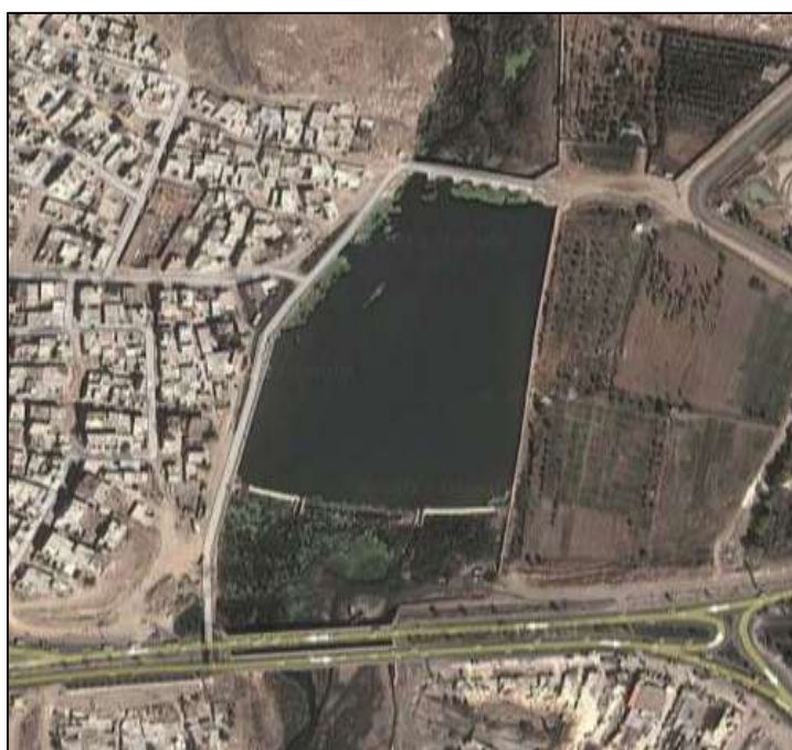
شکل ۵-۲. موقعیت پل قشلاق واقع در شهر سنندج و مناطق مورد بررسی در آن که شامل آبگیر و رود قشلاق در شمال و جنوب آبگیر می شود. (آذر ۱۳۹۱)
