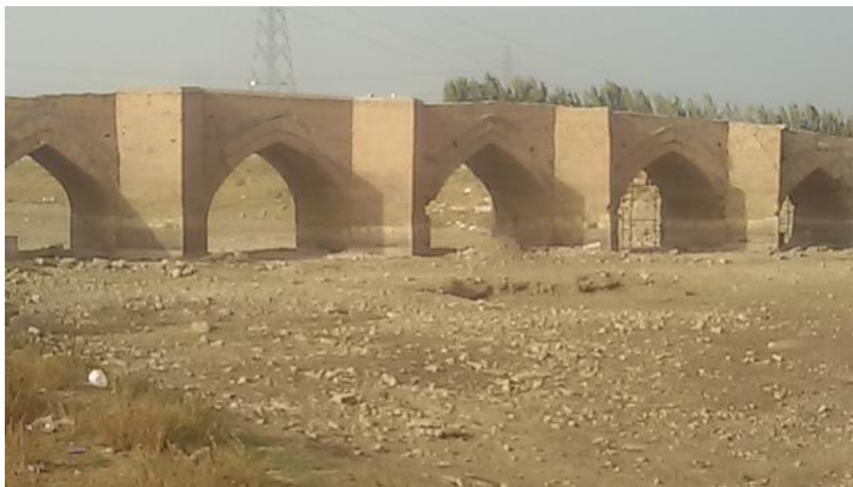
تصویر شماره 12: پل تاریخی سیمینه رود و رودخانه خشک
