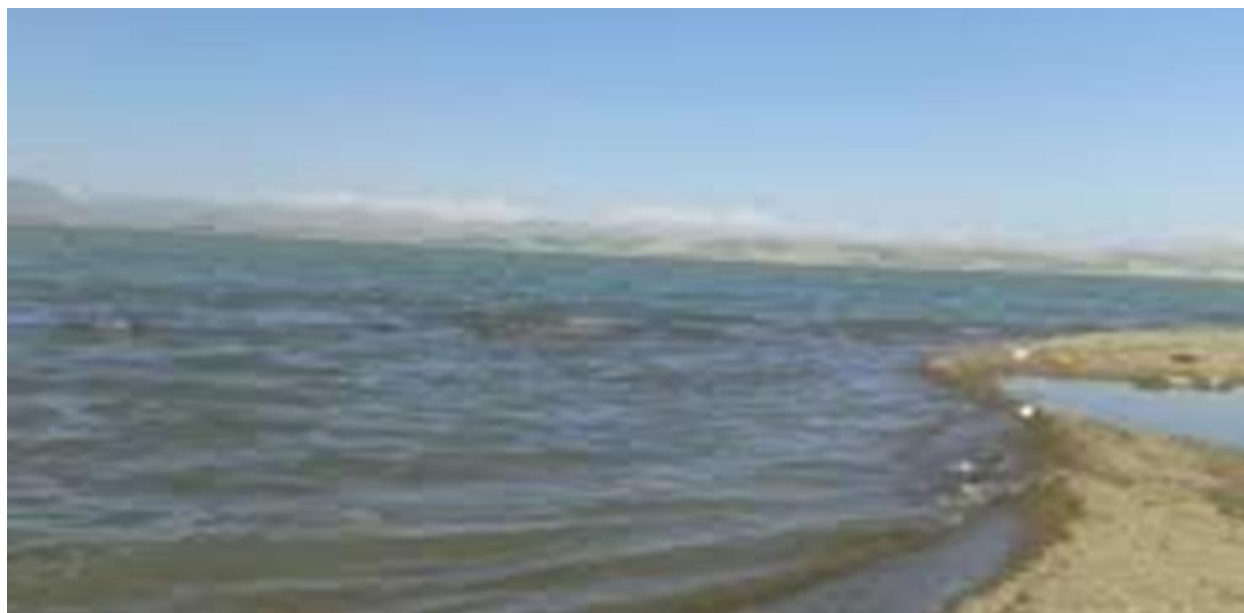
تصوير شماره 4: نمايي نزديك از سد حسنلو
